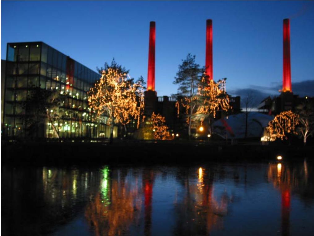
Die Türme vom Werk zu Adventskerzen umfunktioniert – wunderschöner Weihnachts-Ausblick zum Zeithaus und Bentley-Haus
