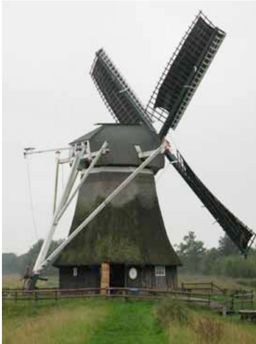
Erdholländer mit Wasserschöpfmühle
